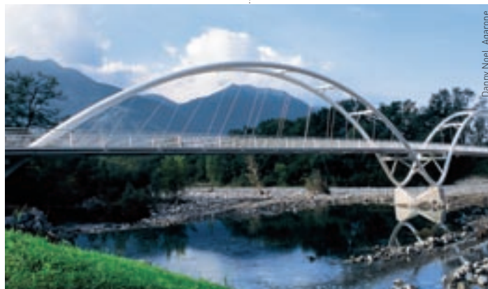
Passerelle über die Verzasca, Tenero-Contra / Gordola: Die 120 Meter lange Passerelle verbindet die Gemeinden Tenero-Contra und Gordola bei der Mündung in den Lago Maggiore und überquert eine natürliche Flusslandschaft.
