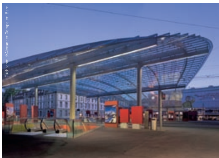
Baldachin, Bahnhofplatz Bern: Ein 85 Meter langes und 40 Meter breites gläsernes Dach überdeckt den Berner Bahnhofplatz. Es überspannt einen grossen Teil des Platzes, der dadurch als Tor zur Altstadt an Prägnanz gewinnt.
