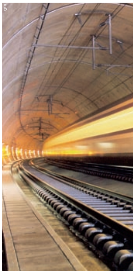
Strahlungskabel (oben links) im Grauholtztunnel.
