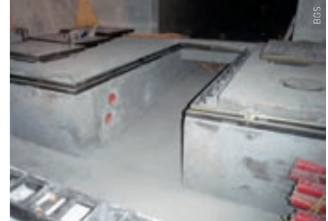
Einbau des Schachtes.
