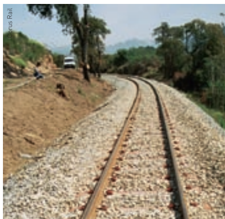
130'000 neue Bahnschwellen aus Metall für die Bahn auf Korsika.
