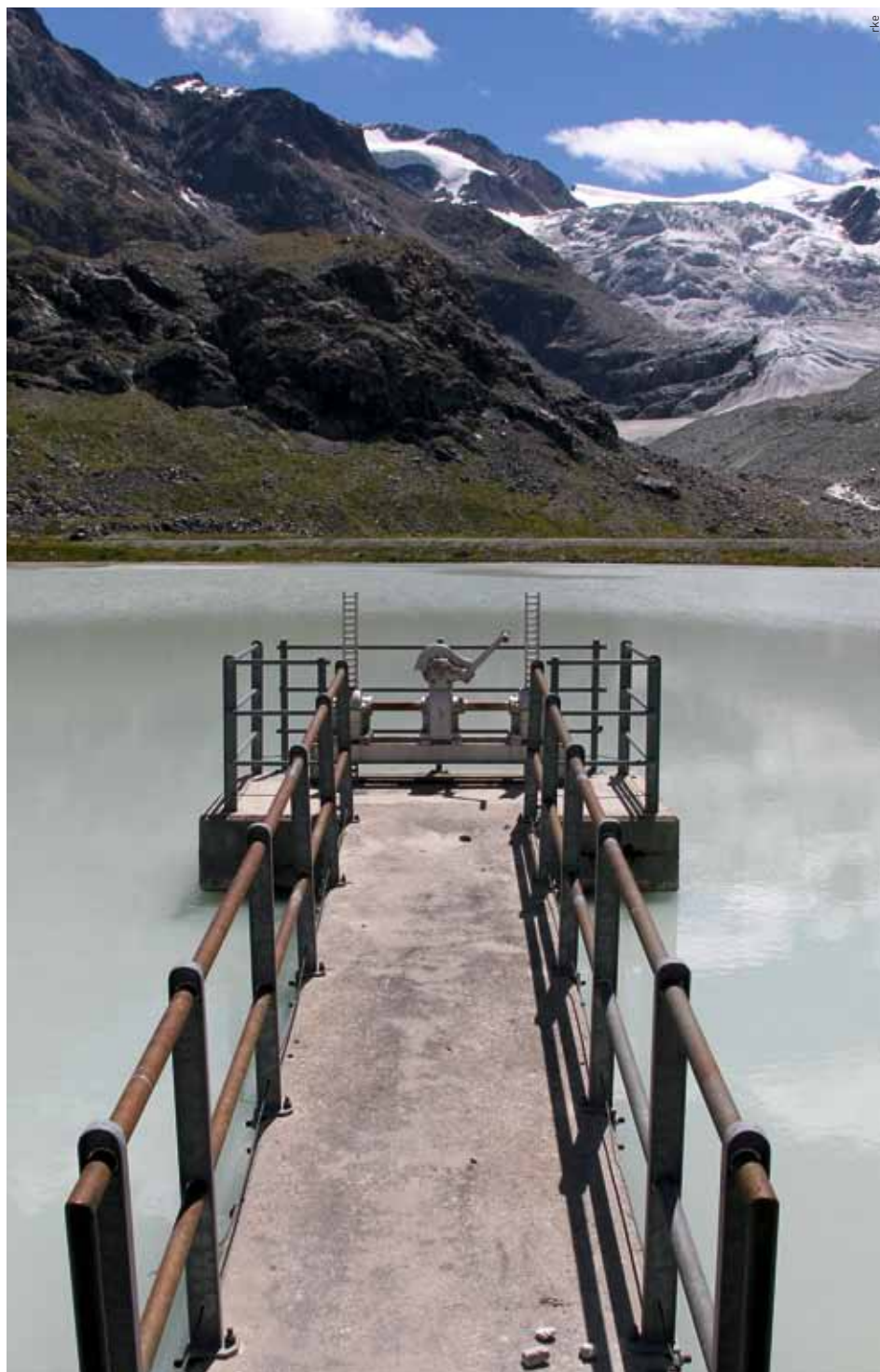
Dessableur destiné à retenir le sable contenu dans l'eau qui sort du glacier de Moiry. La vanne (au centre) permet de faire baisser le plan d'eau (petit lac de rétention) et d'évacuer ensuite le sable retenu pour faire de la place.
