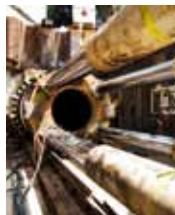
TITELBILD Im Schweizer Untergrund fliesst das Abwasser durch 47 000 km öffentliche Kanalisation in die Kläranlagen. Heute zeigen 25% der Abwasserinfrastruktur Schäden, die repariert werden müssen. Fotograf: Boris Adolf, © by KünzlerBachmann Medien AG, St.Gallen
