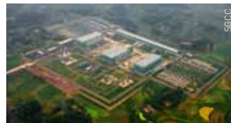
Die Sendestation der 800-kV-UHGÜ-Verbindung im Juni 2010.
