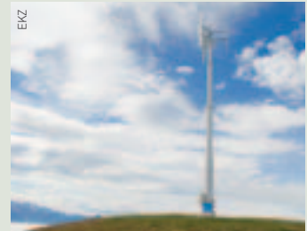
Der H-Rotor hat eine Leistung von 10 Kilowatt bei einer Masthöhe von 25 Metern.
